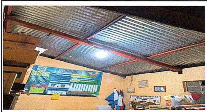
Foto 8: Finalización del sistema eléctrico en dirección, incluyendo foco led, el cual quedó con mejor iluminación.
