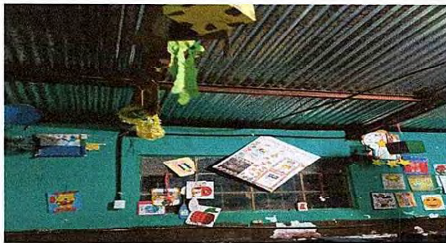
Foto 9: Finalización del mejoramiento del sistema eléctrico principal en aulas.
