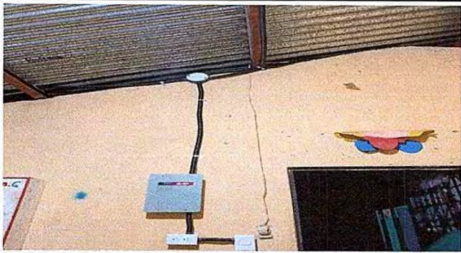
Foto 7: Finalización del mejoramiento del sistema eléctrico en dirección. Instalación de tablero de flípon.
