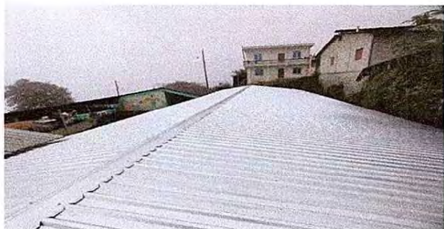
Foto 1: Finalización de sustitución de lámina acanalada en mal estado por lámina troquelada aluzinc calibre 26 (áreas de bodega, aulas y cocina)
