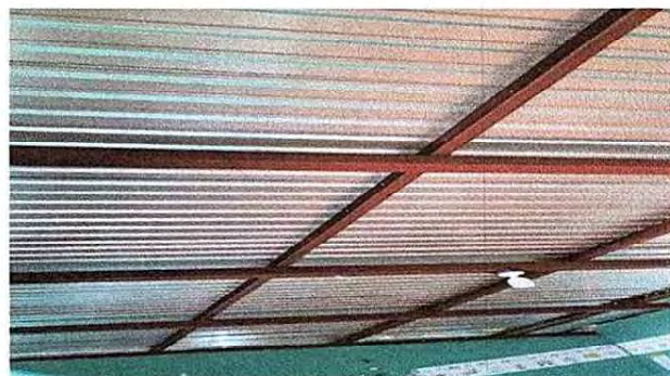
Foto 2: Sustitución de láminas acanaladas por láminas troqueladas aluzinc calibre 26 en aulas.
