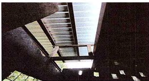
Foto 5: Sustitución de láminas acanaladas por láminas troqueladas aluzinc calibre 26 en cocina para mejorar el ambiente.
