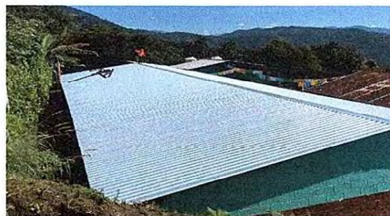
Foto 14: Finalización de sustitución de láminas acanaladas por láminas troqueles aluzinc calibre 26 del área de aulas, bodega y cocina para mejorar el ambiente de la comunidad educativa.
