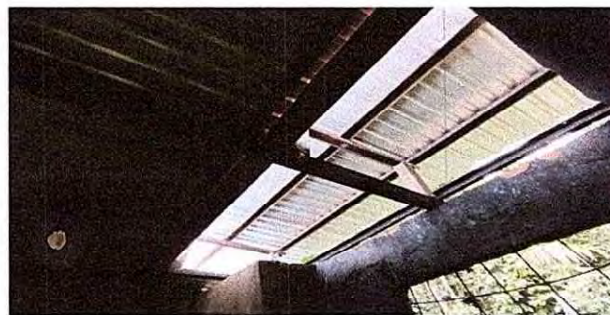
Foto 4: Sustitución de láminas acanaladas por láminas troqueladas aluzinc calibre 26 en cocina.
