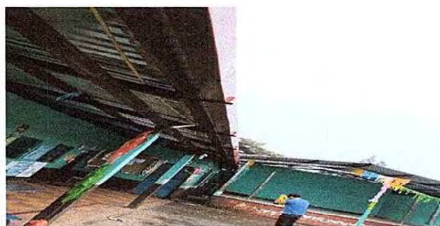
Foto 6: Finalización del mejoramiento del canal metálico y soporte.
