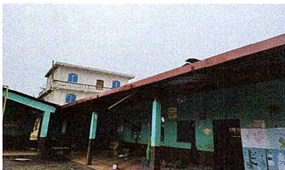
Foto 15: Finalización de sustitución de láminas acanaladas por láminas troqueles aluzinc calibre 26 en el modulo que se priorizo como el mejoramiento de canal metálico.
