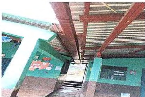
Foto 13: Finalización del mejoramiento del canal metálico y soporte.
