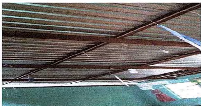
Foto 3: Sustitución de láminas acanaladas por láminas troqueladas aluzinc calibre 26 en aulas.
